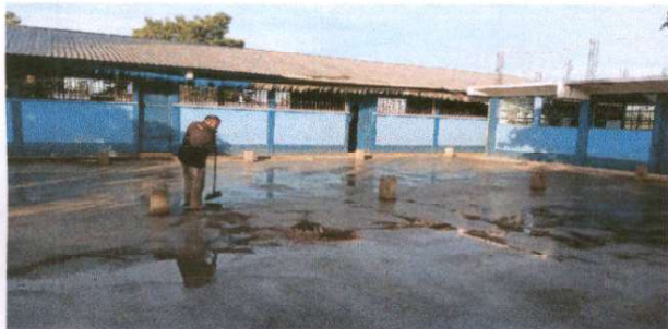
Foto 3: sustrución de suelo, por piso de concreto, módulo de patio
