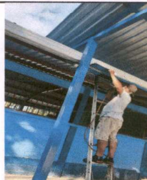
Foto 4: sustrución de canal PVC, módulo de patio
