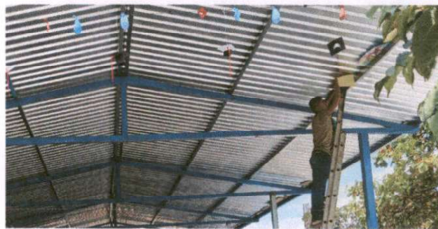
Foto 2: sustrución de estructura de soporte de madera, por metal, módulo de patio
